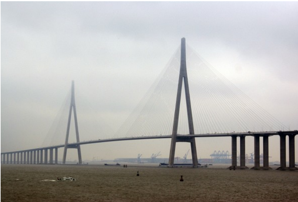
(3) Sutong-Brücke, China, Fertiggestellt 2008, Hauptspannweite 1088 m, überquert den Fluss Jangtsekiang .
